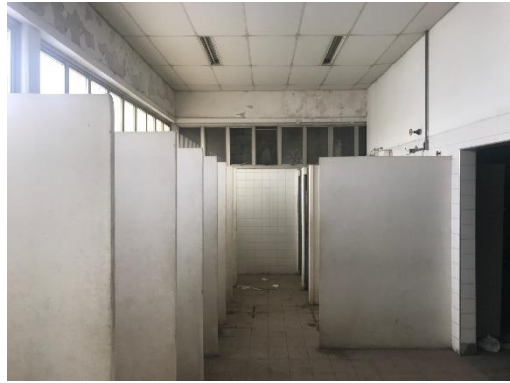
Vista Geral – Administração Sanitário
