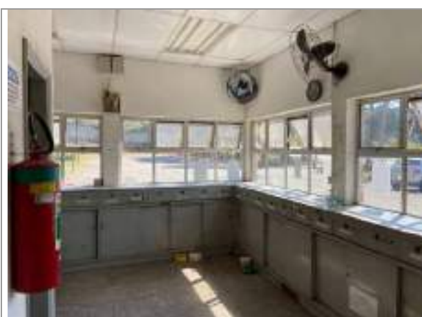
4. Portaria/Cabine de Força
