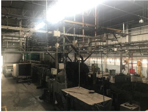
Vista Geral – Galpão / Tratamento Térmico
