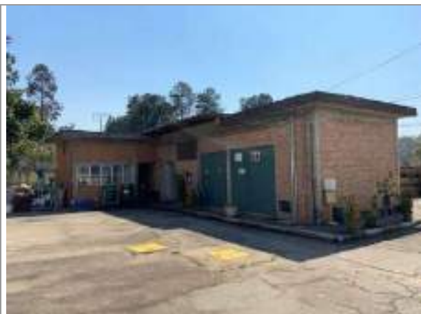
4. Portaria/Cabine de Força
