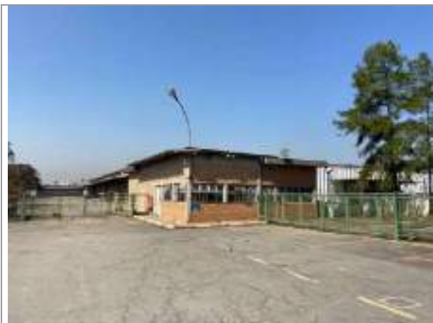
4. Portaria/Cabine de Força
