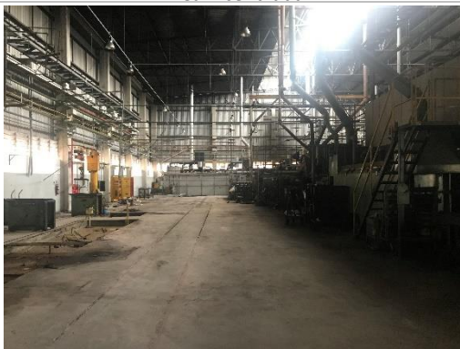
Vista Geral – Galpão / Tratamento Térmico
