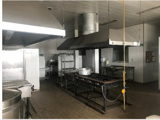
Vista Geral – Administração Cozinha
