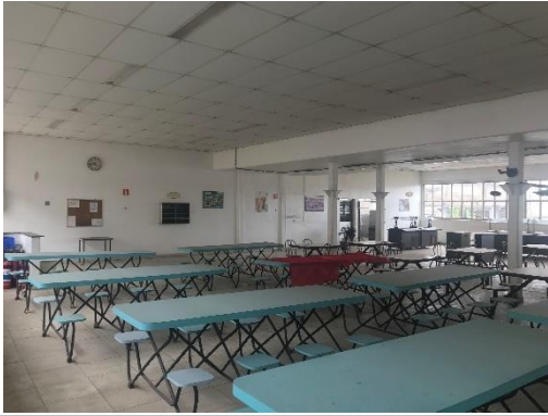
Vista Geral – Administração Refeitório
