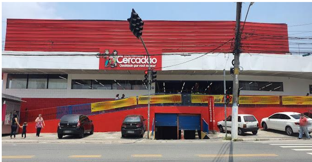
Vista frontal do imóvel avaliado
