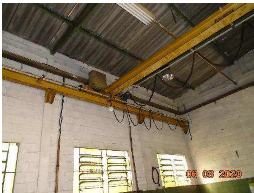
PONTE ROLANTE 1,5 TON VÃO 8M
