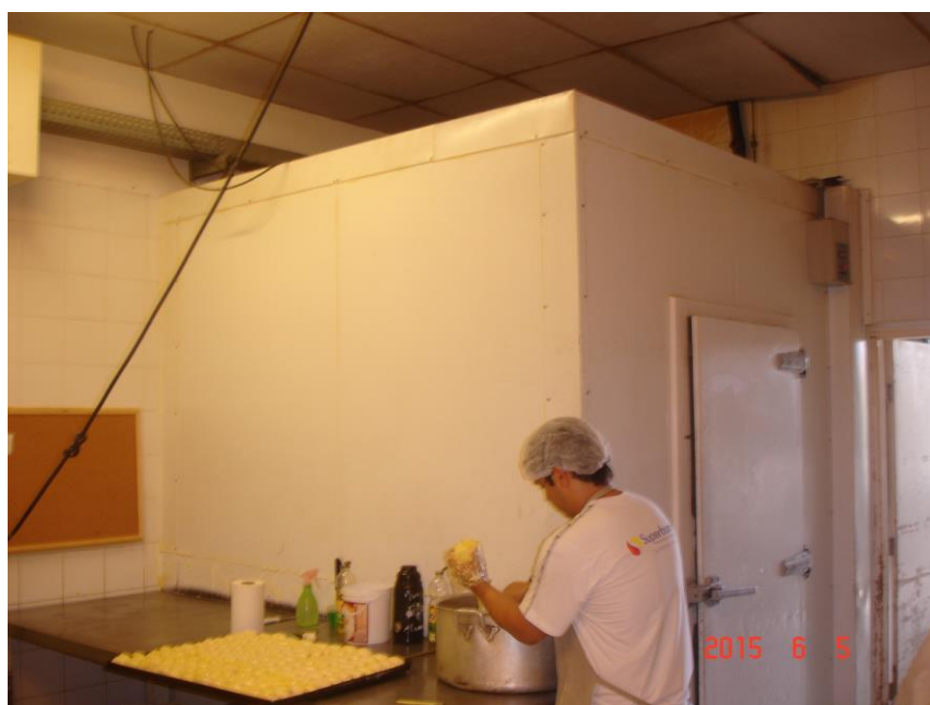
Vista da CÂMARA FRIA, marca MIPAL. Patr. 00144
