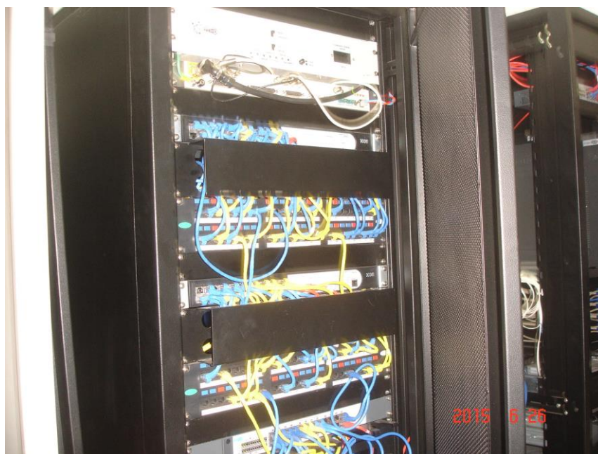
Vista GERAL 1 da SALA DO SERVIDOR
