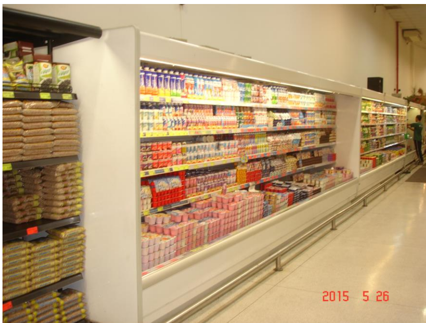
Vista do BALCÃO DE RESFRIADO MONTADO NA PAREDE (IOGURTE), marca HUSSMANN. Patr. 00021
