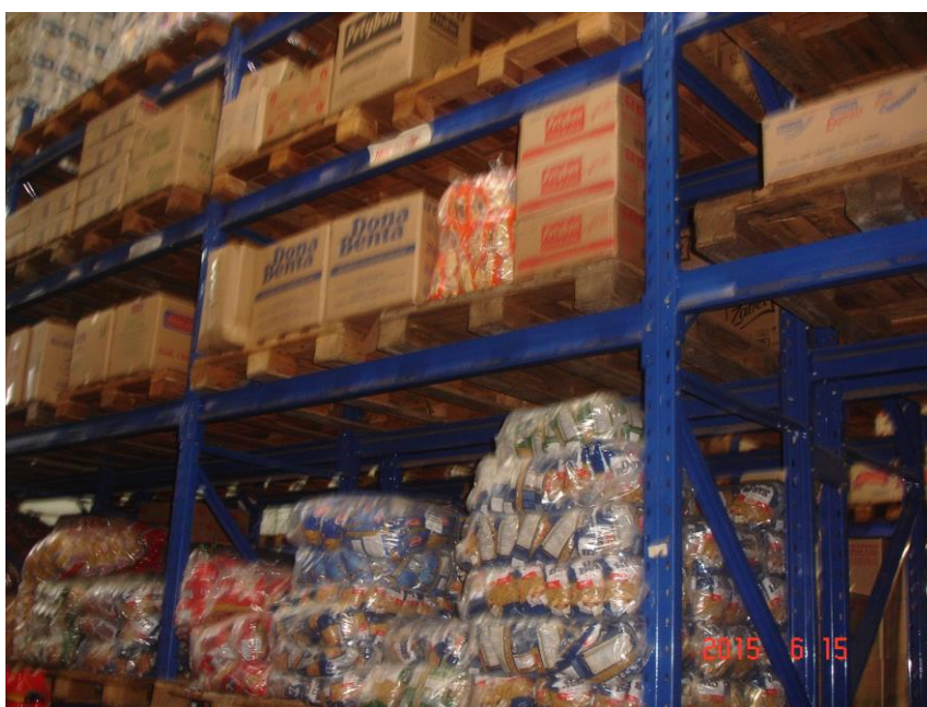
Vista do RACK MATÁLICO PARA ARMAZENAGEM DE PRODUTOS 11 - 02 LADOS CONJUGADOS (BISCOITO e MACARRÃO). Patr. 00317
