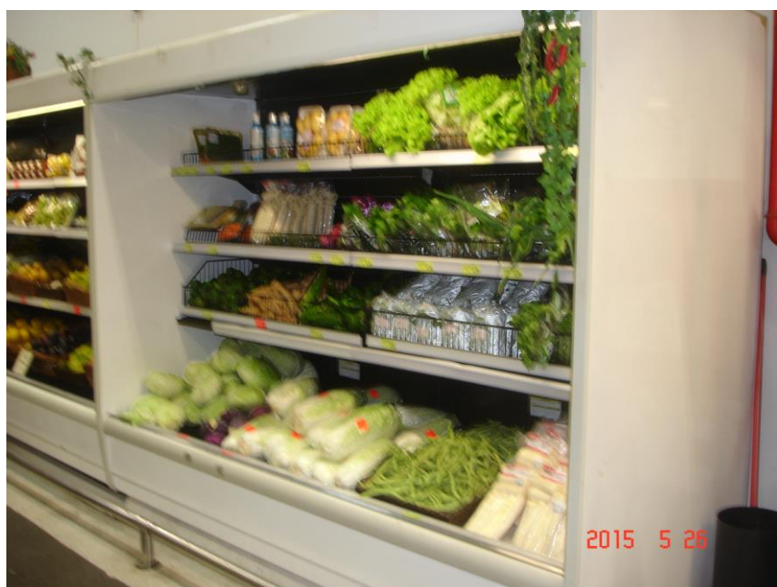
Vista do BALCÃO DE RESFRIADO MONTADO NA PAREDE (VERDURAS), marca HUSSMANN. Patr. 00023
